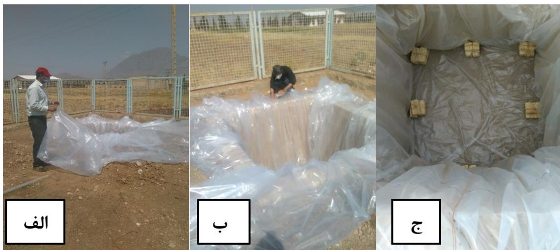
شکل ۲- مراحل استقرار پلاستیک دولایه در حوضچه (از سمت چپ به سمت راست)
