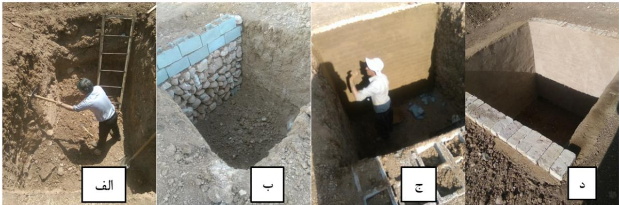
شکل ۱- از سمت چپ به راست مراحل تهیه حوضچه ۸ مترمکعبی
